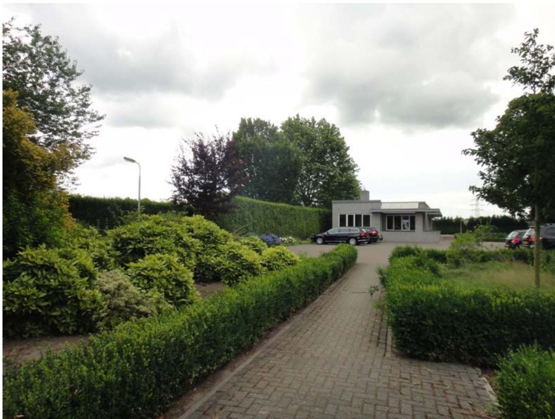
afbeelding 4: foto met uitzicht op kantoorgebouw Bosscheweg 57A (op rechterzijde terrein)
