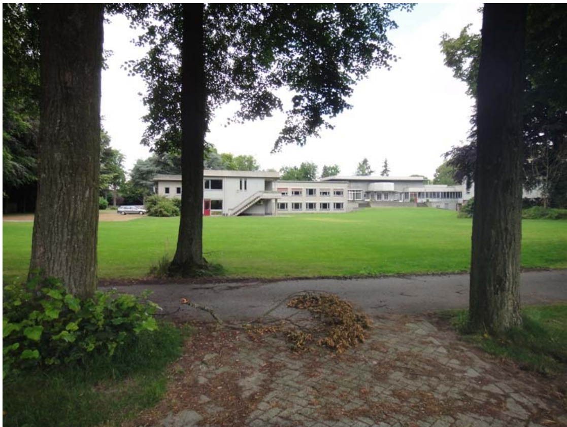
afbeelding 3 : foto met uitzicht op achterzijde kantoorgebouw Bosscheweg 57
