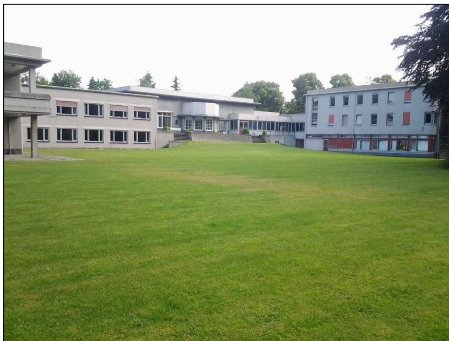
Figuur 3.2 Zicht op het plangebied met de achterzijde van de villa met de twee zijvleugels.
