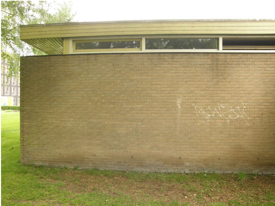
Figuur 5.7: het te slopen schoolgebouwtje is niet geschikt voor vleermuizen; spouwgaten zitten veel te laag en gevelbetimmering kent thans geen gaten die als ingang kunnen dienen
