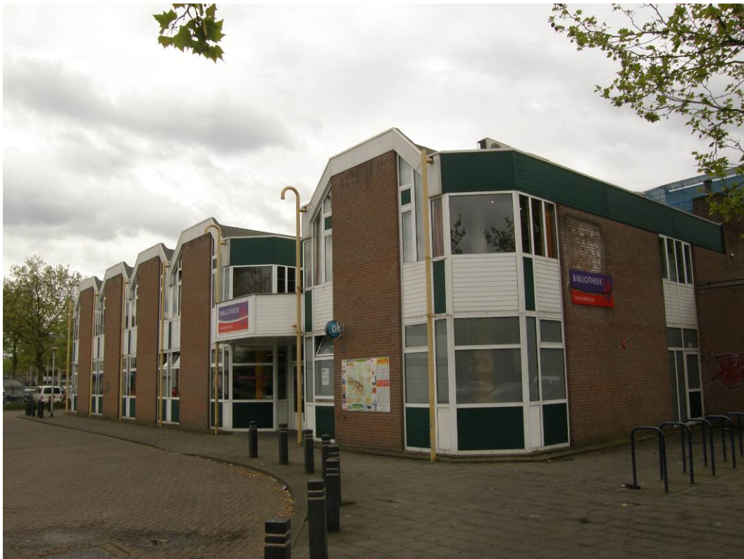
Figuur 3.3: de huidige bibliotheek; deze staat op de lijst om gesloopt te worden
