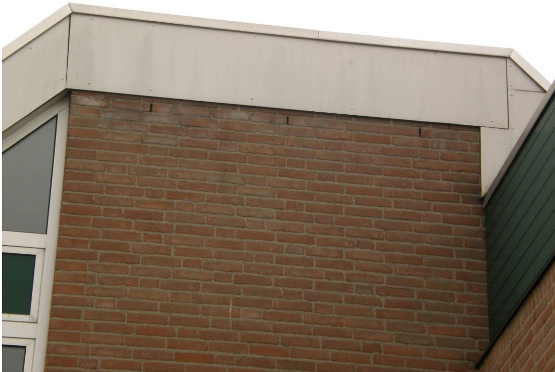
Figuur 5.4: Daklijsten en spouwgaten in de bibliotheek zitten op een goede hoogte om als invliegopening voor eventuele paar- en verblijfplaatsen te dienen voor bijvoorbeeld de gewone dwergvleermuis.
