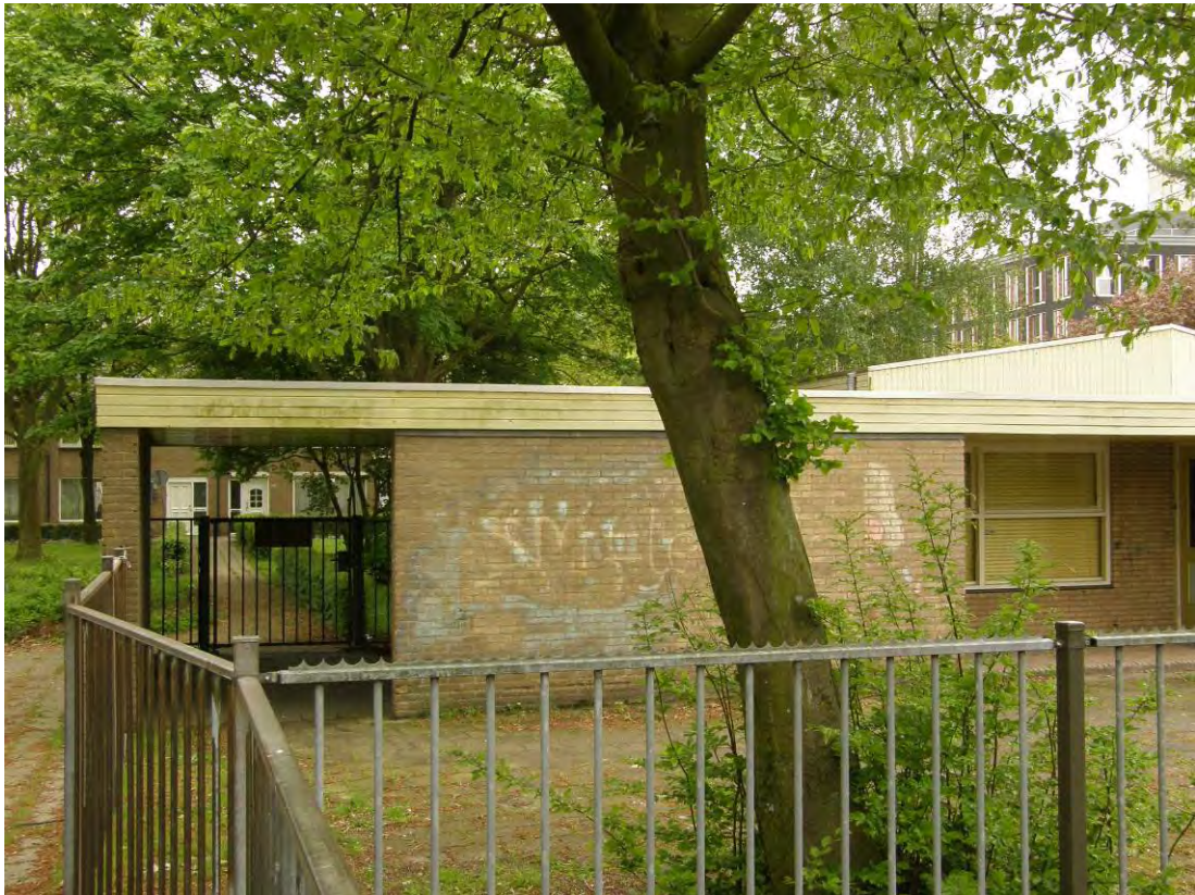
Figuur 3.6: Leegstaande schoolgebouwen in plantsoen in deelgebied 3
