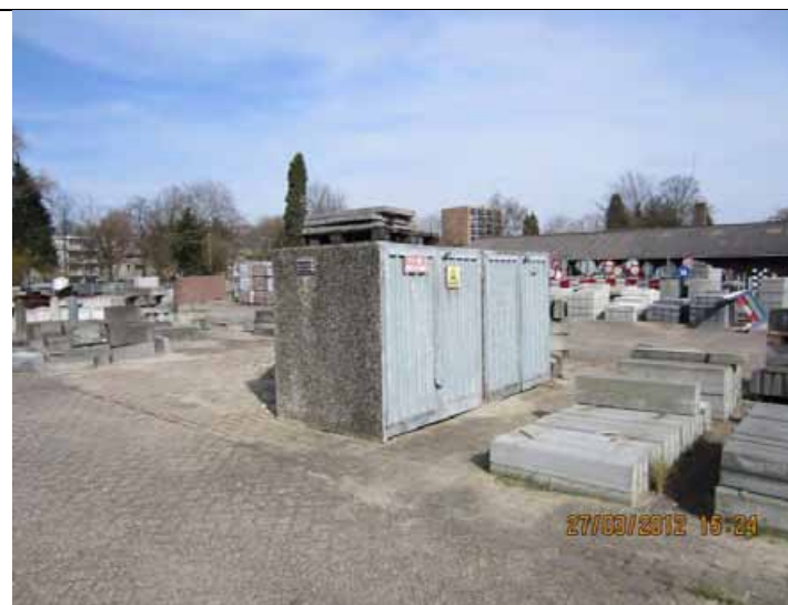
Foto 10 – 12. Benzine- en dieselcontainers
