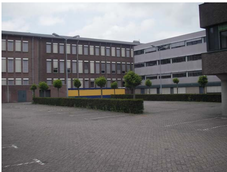
Figuur 15: Het plangebied nabij boorpunt 2, gezien in noordwestelijke richting
