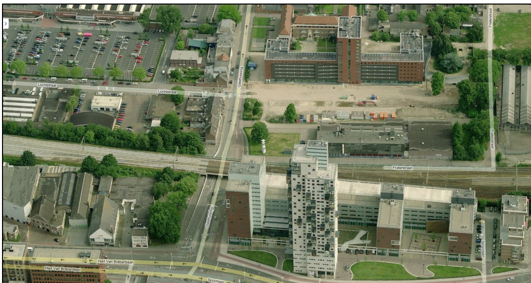
Figuur 4: Zicht op de bouwlocatie vanuit het zuiden (bron:maps.bing.com)
