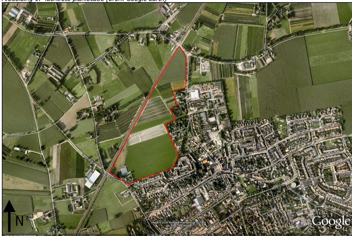
Afbeelding 1: luchtfoto planlocatie (bron: Google Earth)
