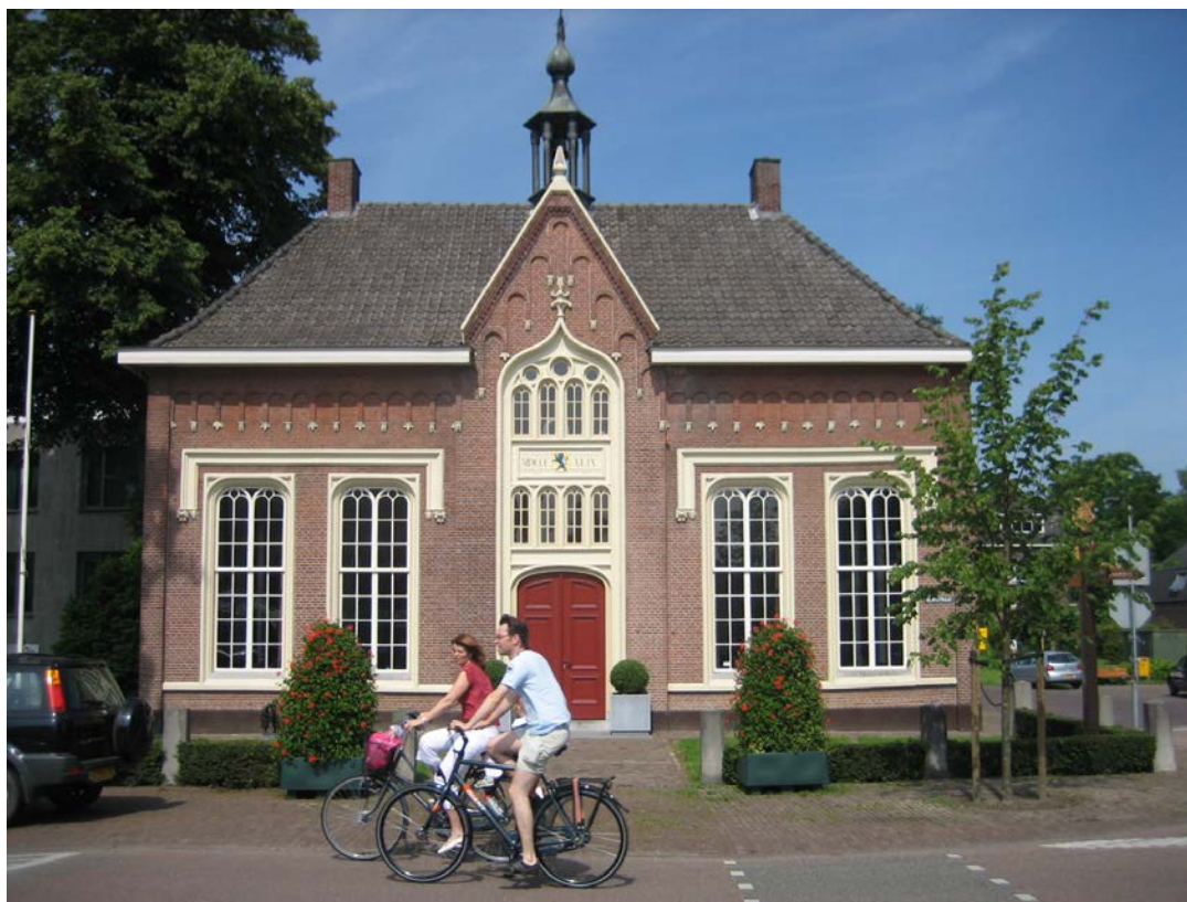
Fig. 9: Het voormalige raadhuis aan de Slimstraat, een rijksmonument. (foto H. van Dijk, juni 2007).
