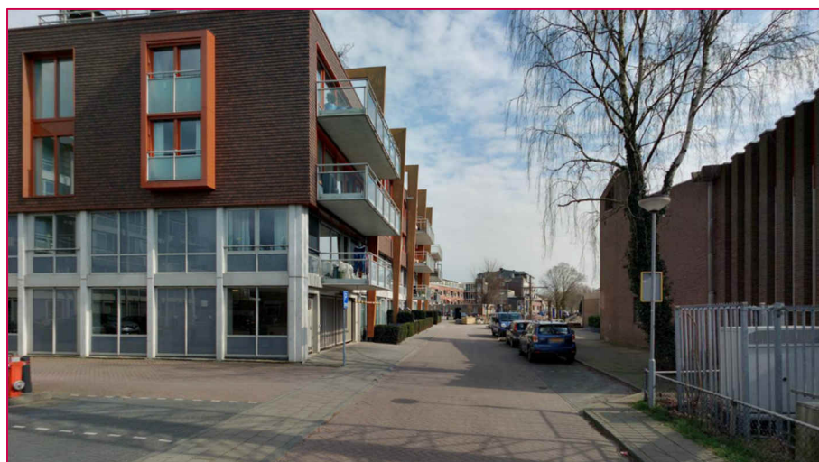
Figuur 3.1: De Werf, gezien vanaf het parkeerterrein
