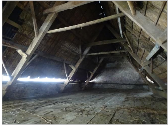
Foto 15: Impressie zolderruimte schuur Langeweg 93 te Kruisland.
