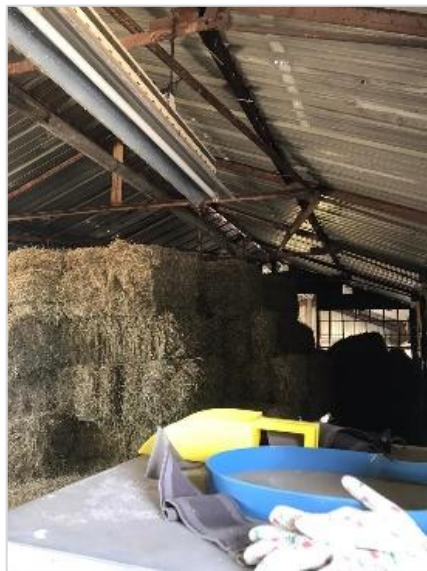
Foto 8: Te slopen schuur.
