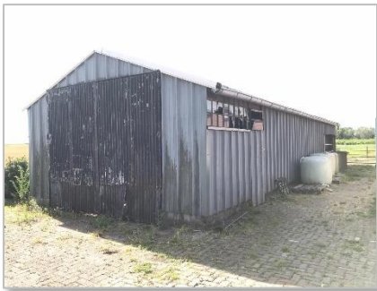
Foto 2: Te slopen schuur .
