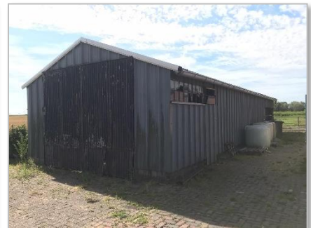
Foto 4: Te slopen schuur.
