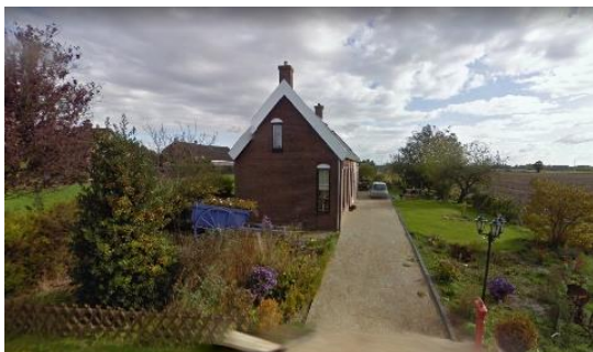
Zicht op de bestaande woning vanuit het westen
