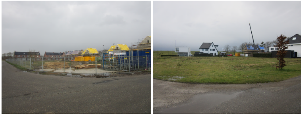
Figuur 5.2. Impressie bouwkavels met huizen in aanbouw.
