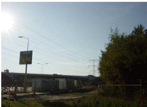
Viaduct bedrijventerrein Ekkersrijt 2000/6000 (nummer 5 op de afbeelding situatie A50 anno 2009)
