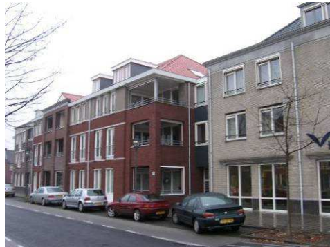
Appartementengebouwen Hendrik Veenemanstraat-Wilhelminalaan
