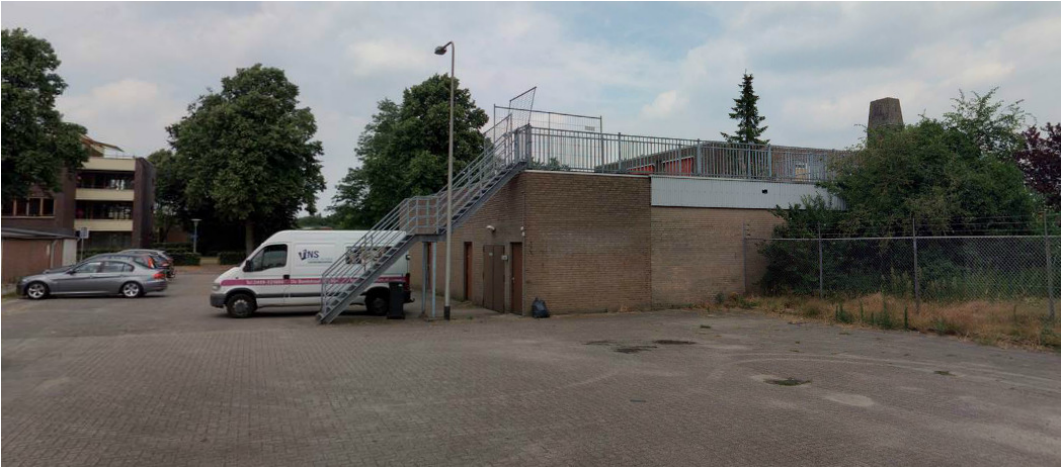
Achterzijde bedrijfspand gezien van het parkeerplein
