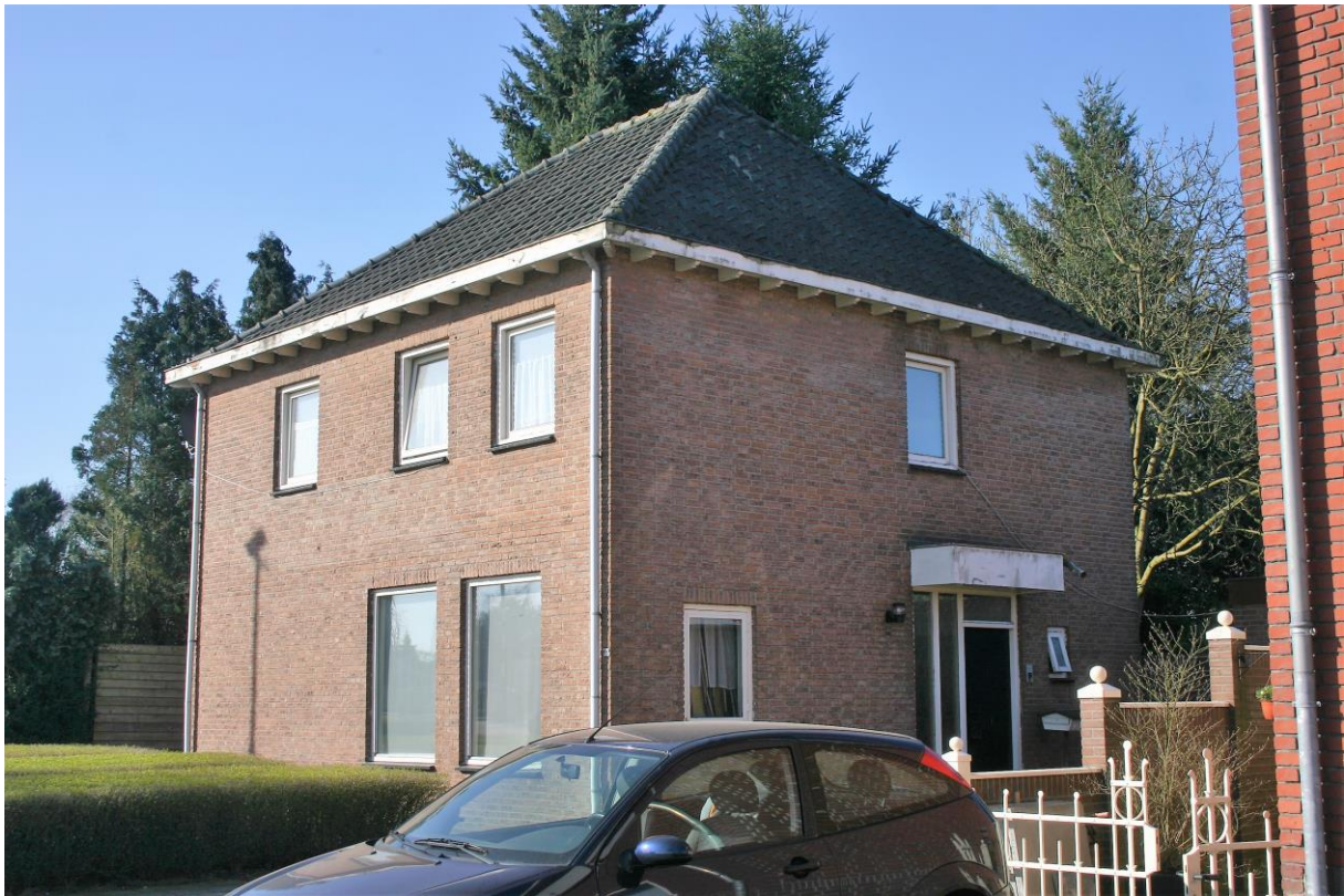
Figuur 12. Het te slopen huis aan de Nieuwstraat 98 (voorkant).
