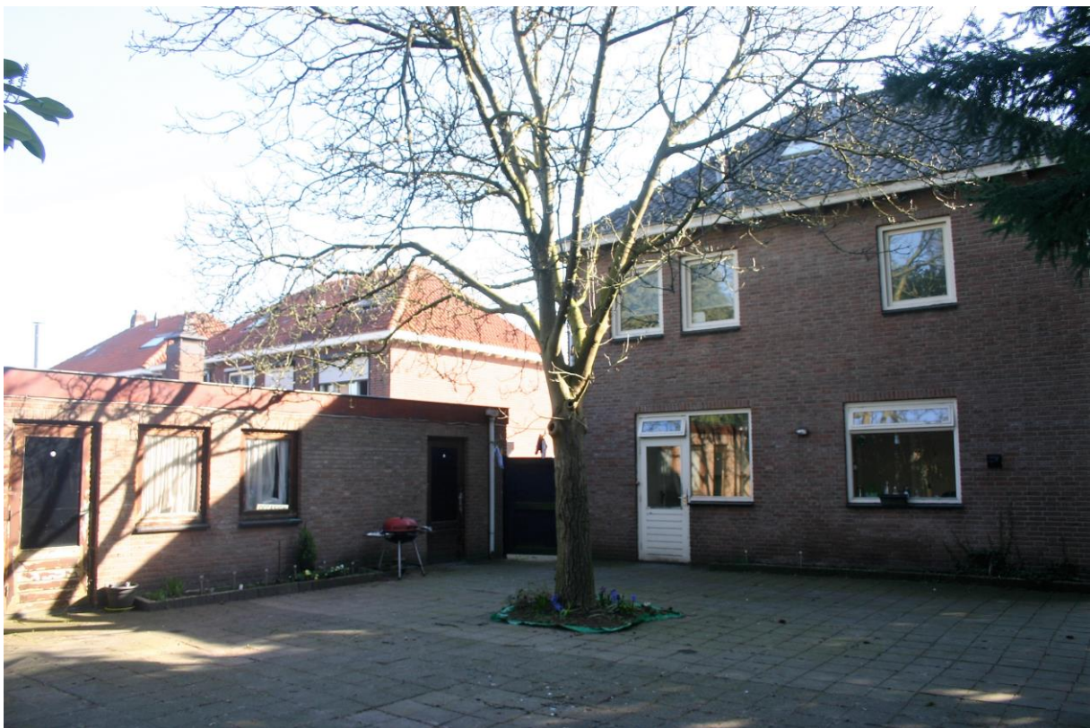
Figuur 13. Het te slopen huis aan de Nieuwstraat 98 (achterkant).
