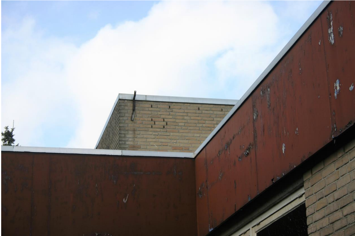
Figuur 18. Open stootvoegen in het bovenste deel van de meubelwinkel.
