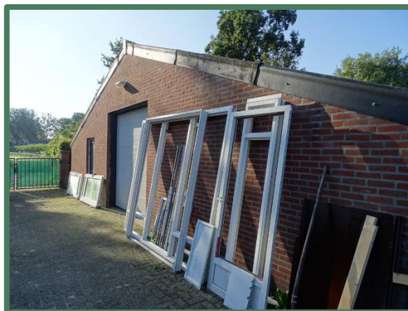
Te slopen noordzijde loods op 503
