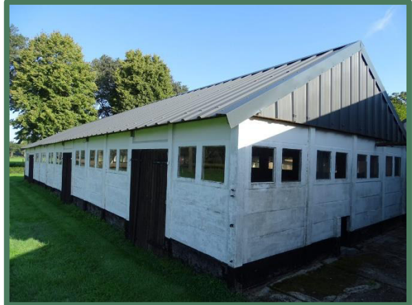
Overzicht voormalige kippenschuur op 772
