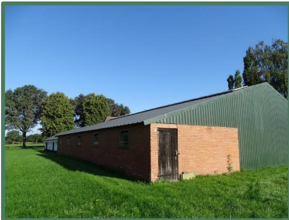
Overzicht loods op 772
