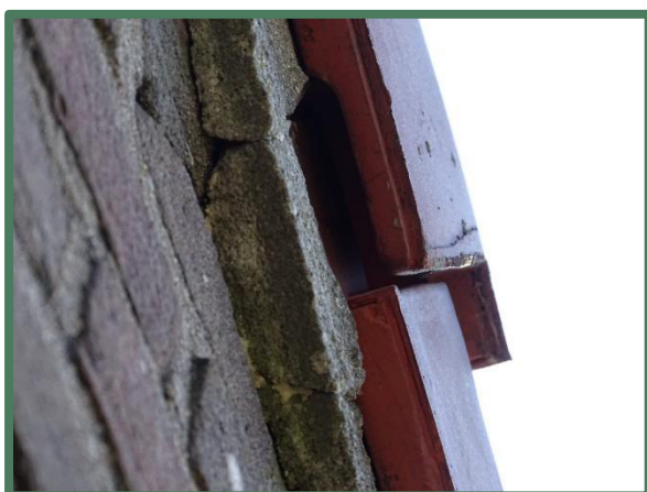
Ruimte tussen de randpannen
