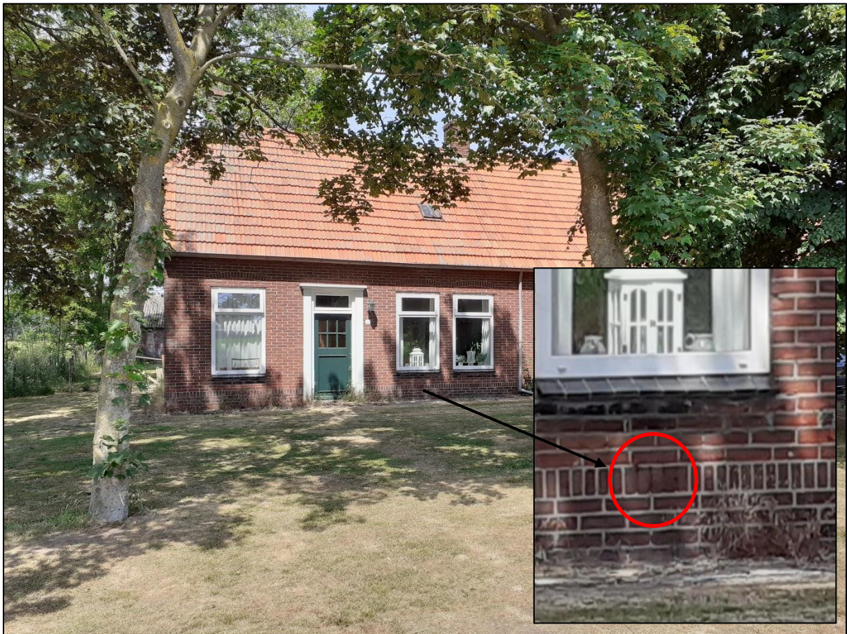
Afbeelding 15. Detail zijgevel woning. Hier bevinden zich ventilatiesleuven, echter kunnen geen sporen aangetroffen worden die duiden op gebruik door vleermuizen. Door de lage hoogte van de openingen valt dit ook niet te verwachten.
