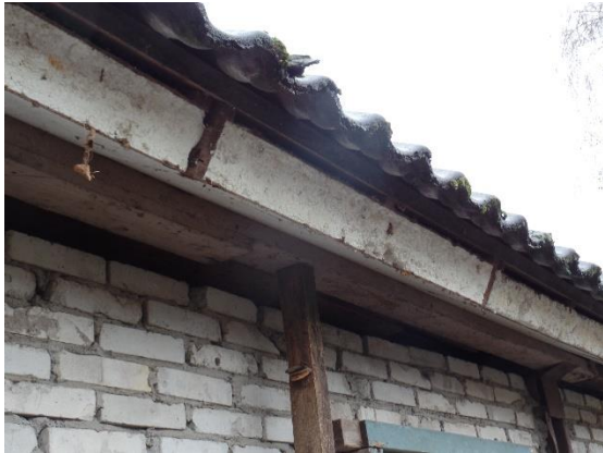
Fig.14. Dakrand van stenen schuur
