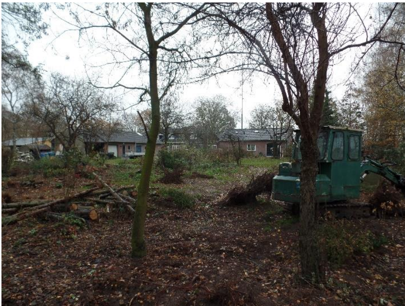
Fig.4. Noordwesthoek van tuin met een te slopen houten gebouw
