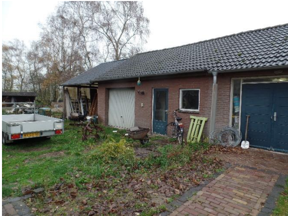
Fig.6. het deel van de stenen schuur dat gesloopt wordt.
