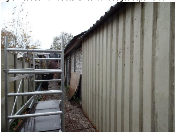
Fig.8. Achterkant van het deel van de stenen schuur dat gesloopt wordt. Vooraan metaal van het aangebouwd afdak en daarachter binnenmuur van kalksteen. Buitenmuur ontbreekt.
