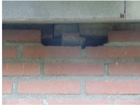
Fig.15. Beschadiging aan bovenrand van muur
