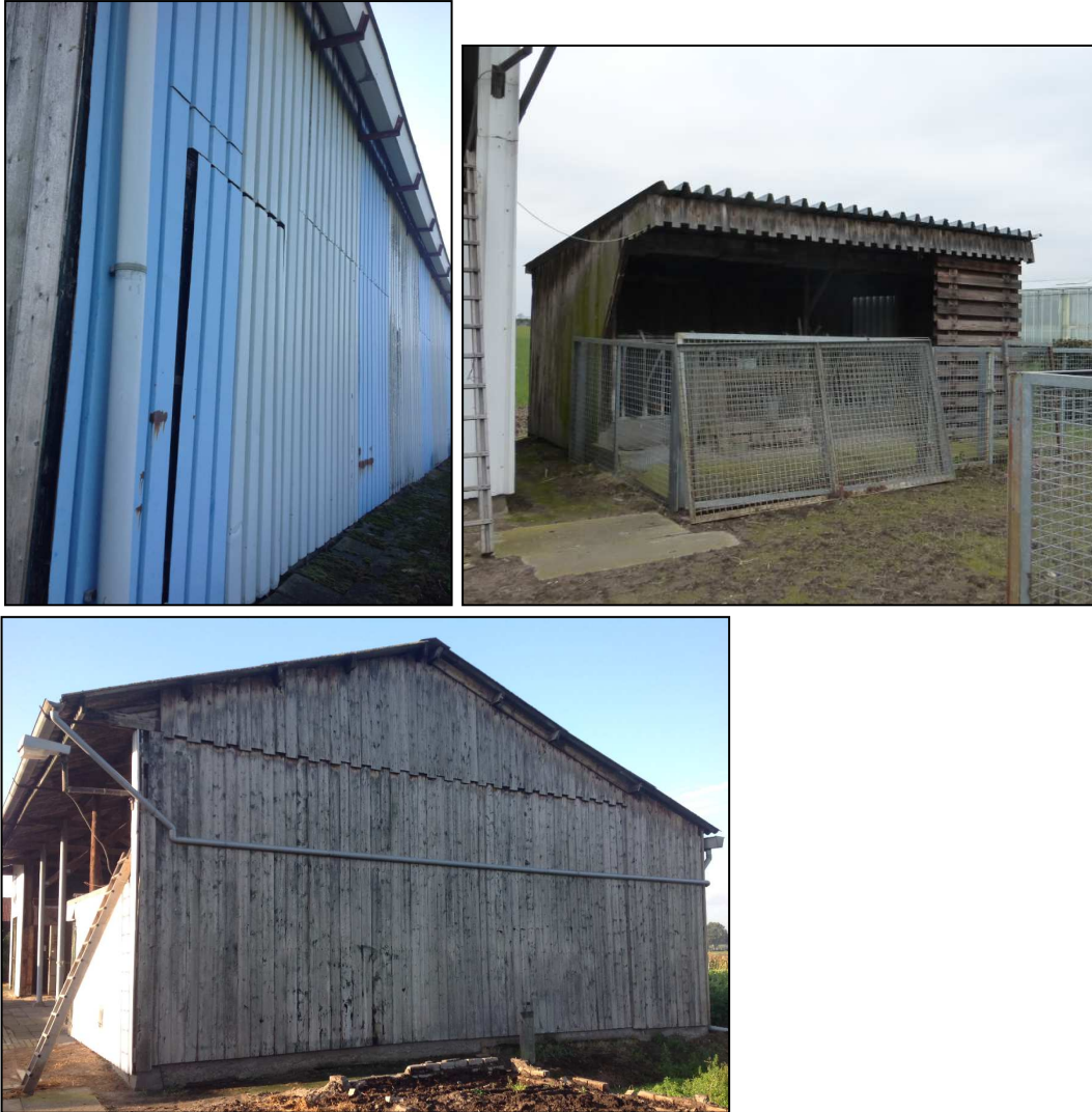
Figuur 22: Beelden van de te slopen (delen) van de opstallen
