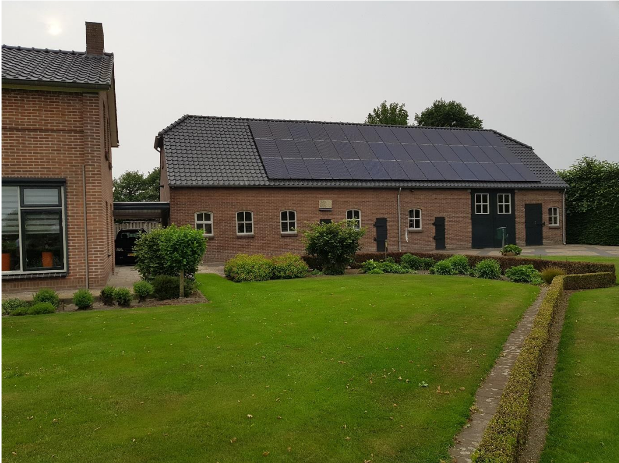
Bijgebouw bij woning (aan noordzijde van de woning)
