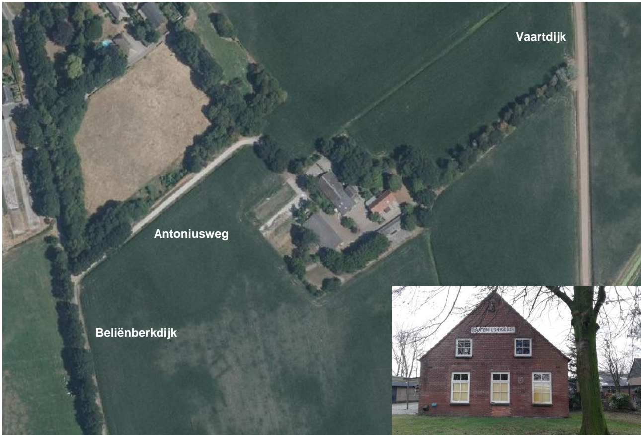
Luchtfoto locatie Antoniusweg 21 (bron: pdokviewer.pdok.nl).
