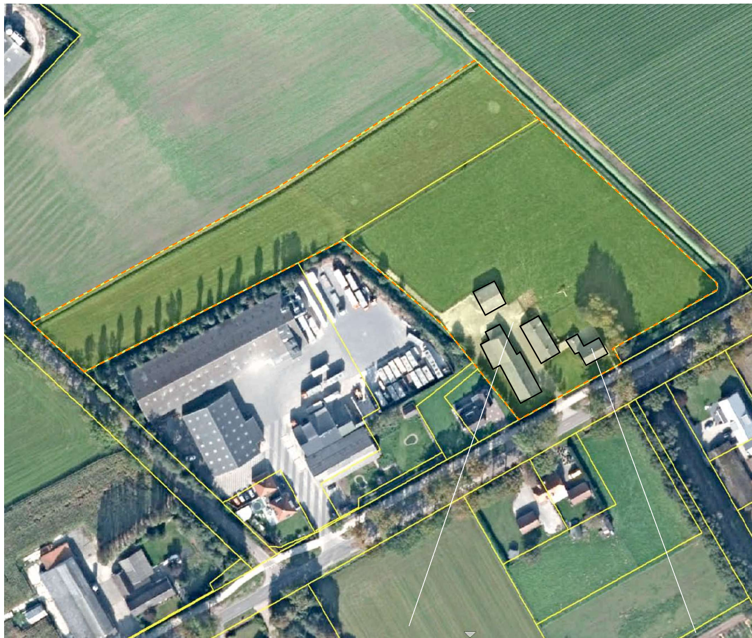
drie bedrijfsgebouwen en verhardingen
