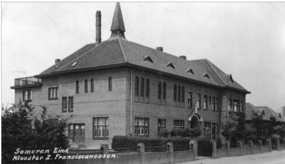
Foto van Sint-Antoniushuis aan de Nieuwendijk rond 1940. Naast het huis stonden 2 vrijstaande gebouwen met 1 laag en kap in dezelfde stijl/architectuur als het klooster.
