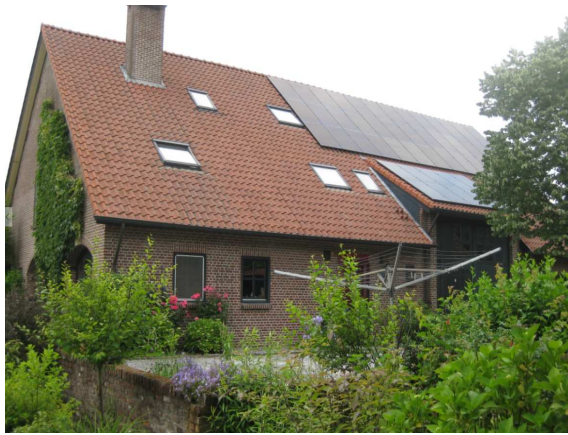
Figuur 8: Woonhuis aan Nederweertseweg 34 en garage
