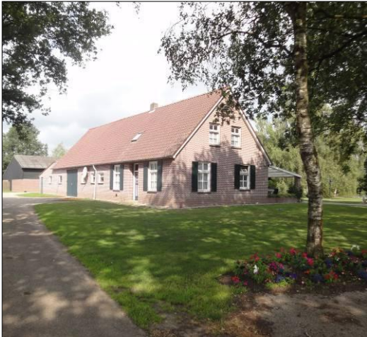
(bedrijfs)woning aan de Kuilerstraat 25
