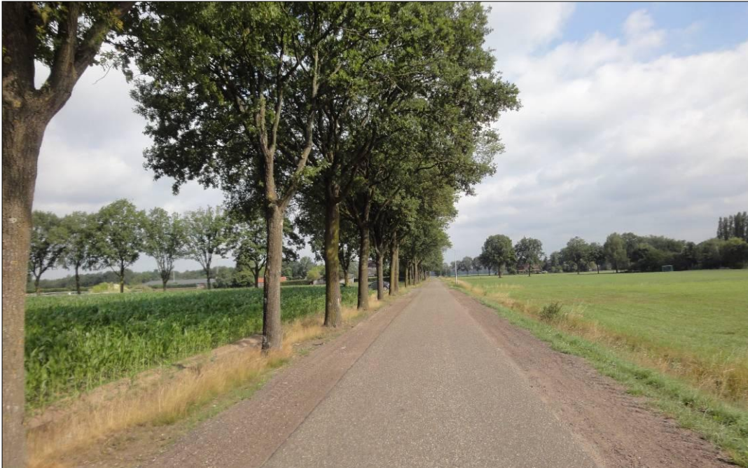
Kuilerstraat richting het noorden gezien
