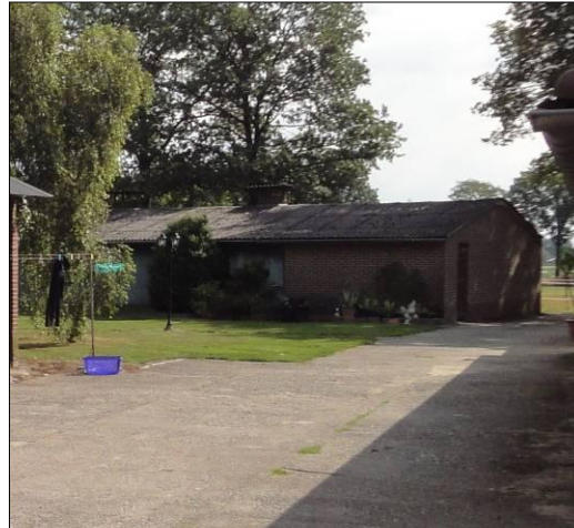
te slopen bebouwing
