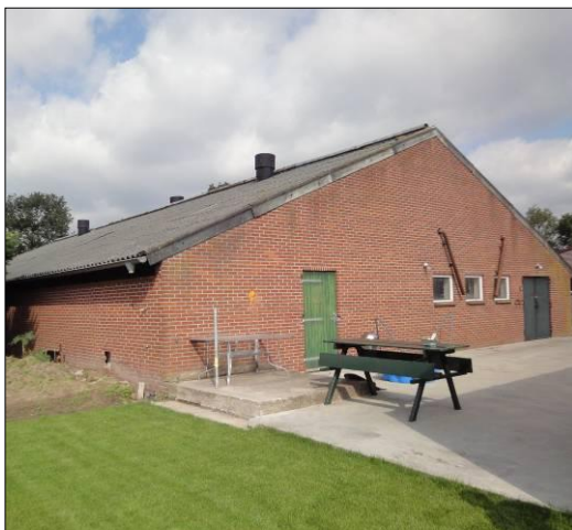
tot greenkeeperloods te verbouwen bijgebouw
