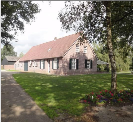
bestaande woning Kuilerstraat 25
