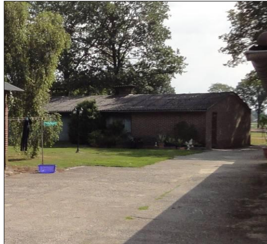
te slopen bebouwing
