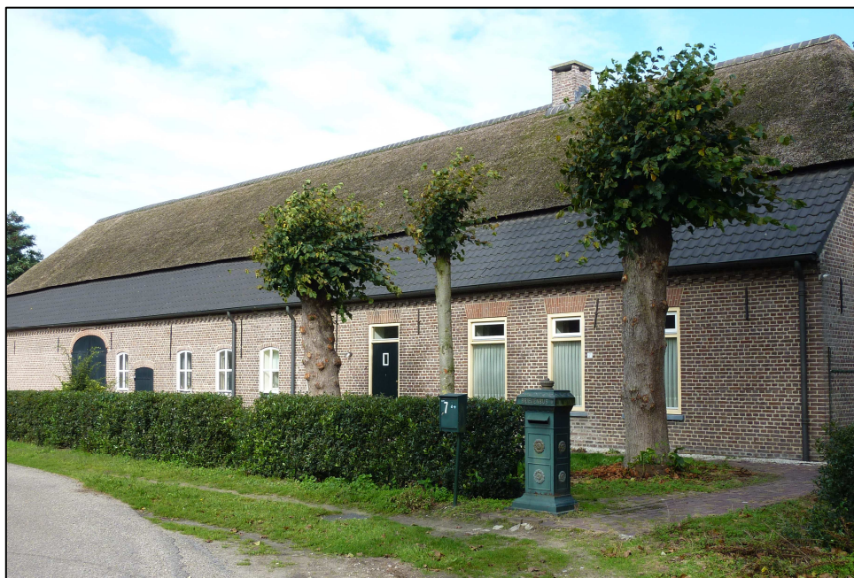
Figuur 3: Langgevelboerderij aan Moorsel 7
