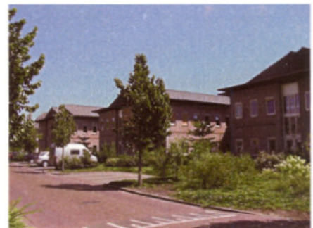
8. Aanbouw langs de straat
