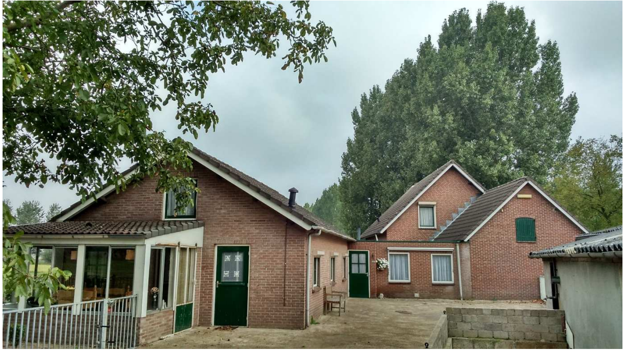
Foto 7: overzicht van het erf, vanaf links te zien: serre, bijgebouw Kremsele 4a, woning Kremsele 4, schuur
