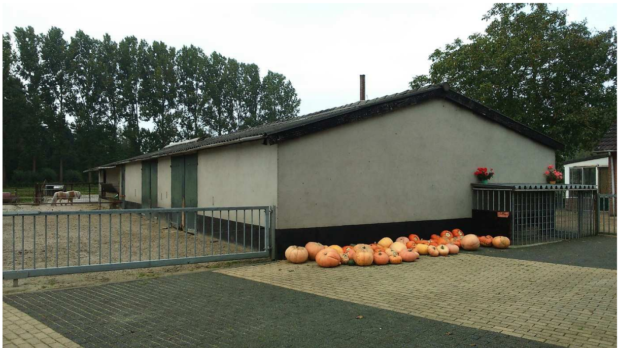
Foto 6: de bestaande, deels te slopen en deels te renoveren schuur
