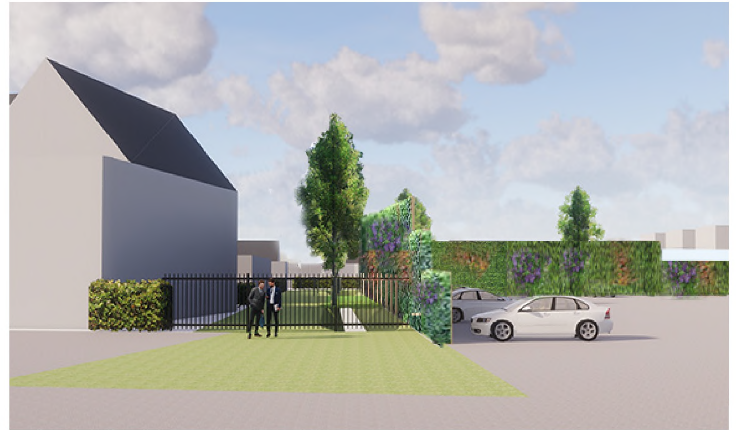
Geluidsscherm type Noise Reducer type SA-80 begroeid met een mengsel van klimplanten en elzen in de groenstrook.
