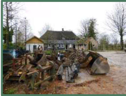
Achterzijde woning met bijgebouwen en opslag
