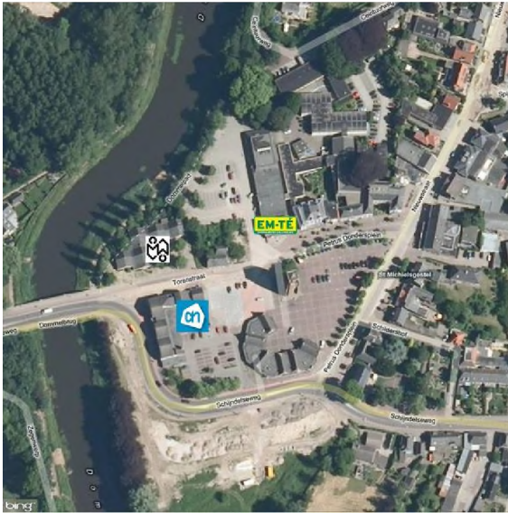
Luchtfoto huidig centrumgebied
