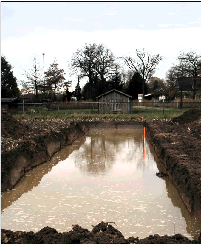
Afbeelding 4: Werkput 10 gezien naar het noorden: direct na de aanleg van het vlak kwam het grondwater omhoog. Al snel stond het water meer dan 30 cm hoog.
