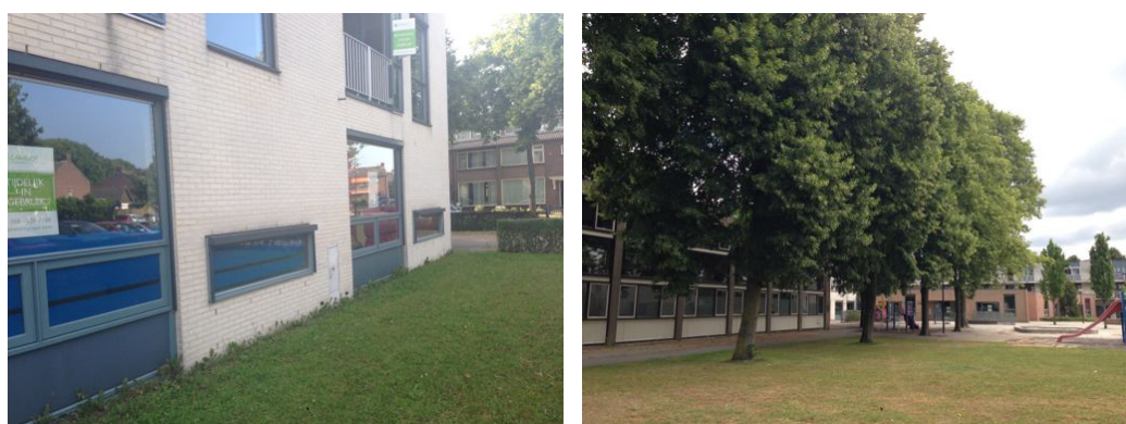
Figuur 3 Het 'Regenboog-complex' heeft in de buitengevel veel open stootvoegen die toegang tot de spouw mogelijk maken. Het complex heeft dan ook potentie voor gebouwbewonende vleermuizen. Op en nabij de planlocatie zijn diverse bomenrijen aanwezig die mogelijk onderdeel uitmaken van een vlieg- en foerageernetwerk.
