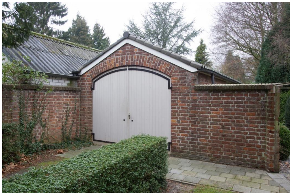
Afbeelding: Garage uit de bouwtijd.
