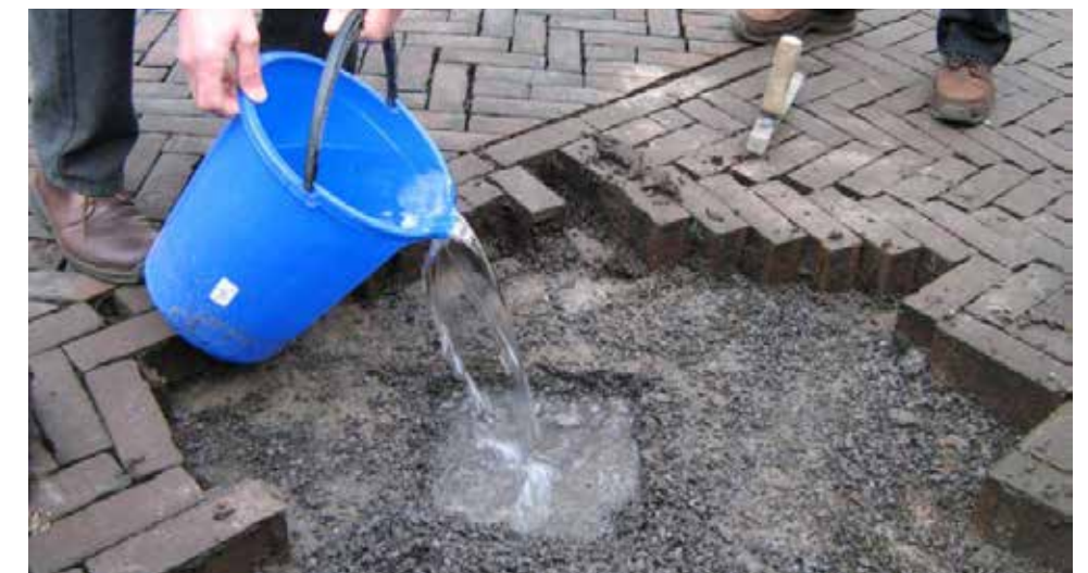
Waterpasserende gebakken klinker met speciale fundering
