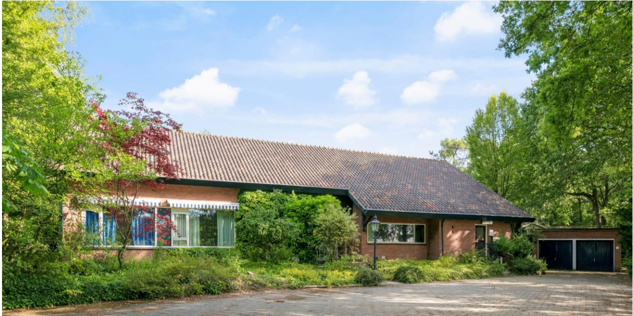
Vorgevel woning / praktijkruimte
