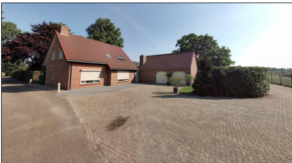
Aanzicht bestaande woning aan de Beatrixweg 36. Bron: cyclomedia, 2019.
