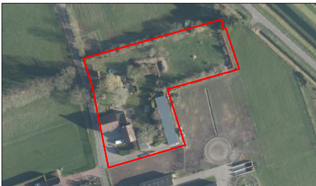
Satellietfoto ter hoogte van de Beatrixweg 36 te St. Willebrord. Met de rode contour is het plangebied geduid. Bron: cyclomedia, 2019.
