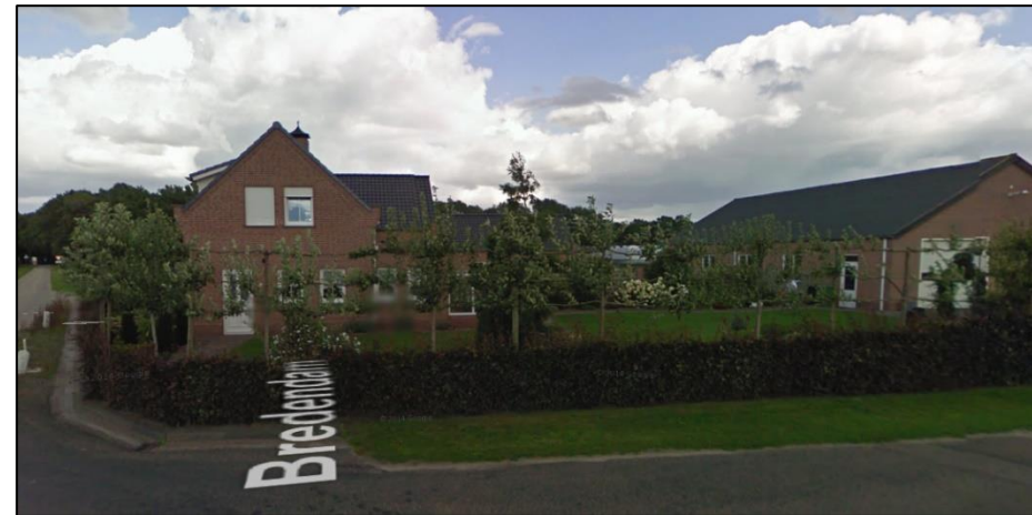
Figuur 13: aanzicht westzijde (Google Streetview)
