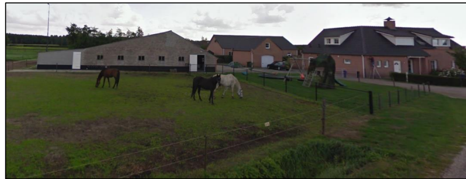
Figuur 11: Zicht vanaf de noordelijke perceelsgrens (Google streetview)
