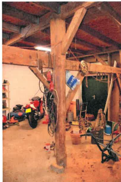
Links: standvink met gebintkoppelbalk. Rechts: het voorste gedeelte van de schuur naar de achtergevel gezien.
