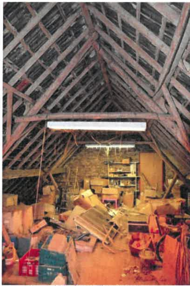
Links: sporenkap met A-spanten. Rechts: sporenkap met A-spanten.
