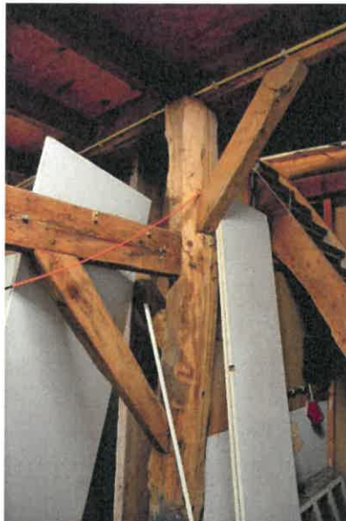
Links: detail gebintstijl met schoren en gebintkoppelbalk. Rechts: gebint met telmerk II.
