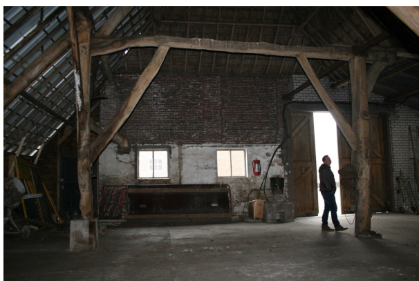
Eerste gebint vanaf de achterzijde
