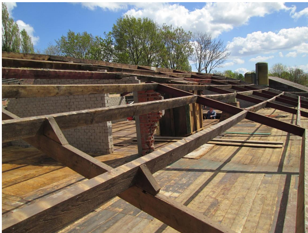
Figuur 3. Het deel van de schuur dat gesloopt wordt, en waarvan het dak is verwijderd.
