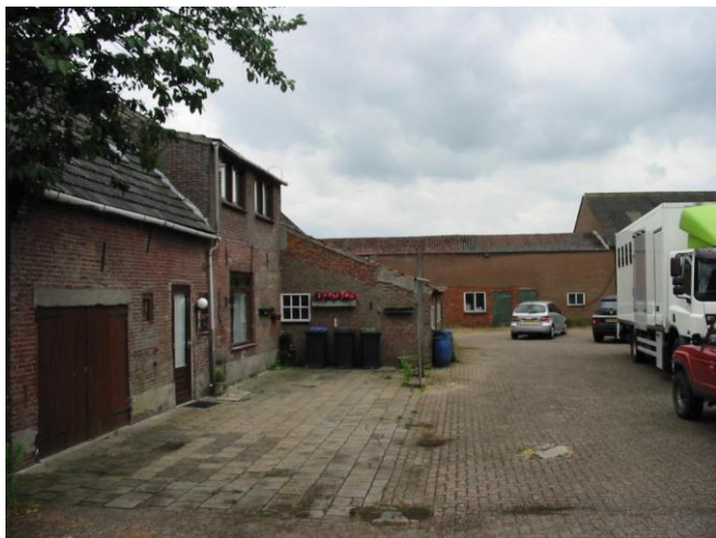
Foto 2: zicht op woning en koeienstal
