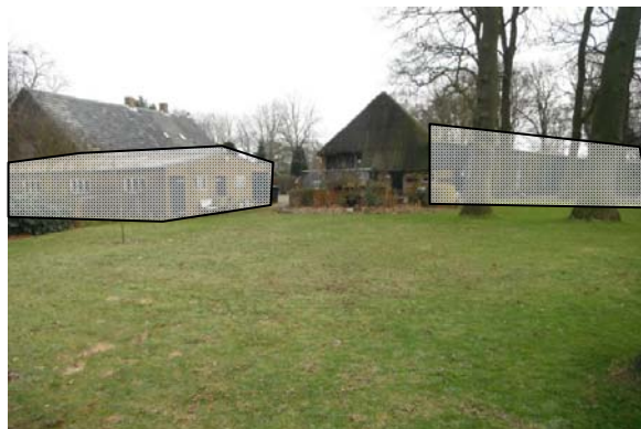
Achteraanzicht met te slopen bebouwing (opgelicht)
