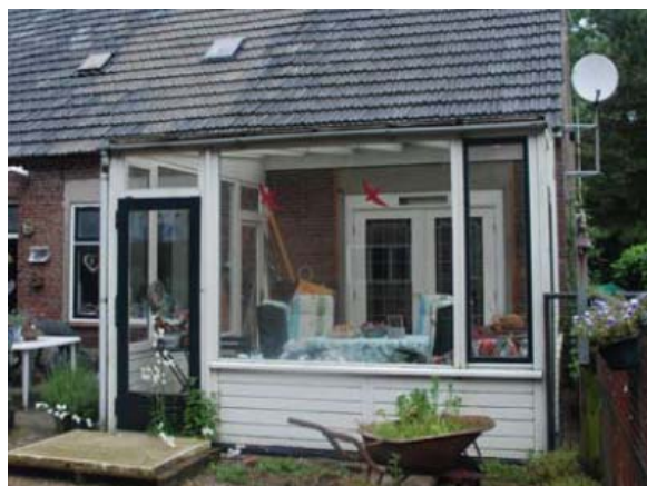
Te slopen aanbouw
