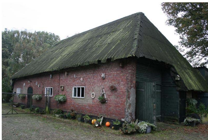
Rechterzijgevel vanaf de achterzijde
