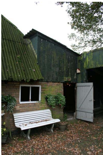
Aanbouw tegen de linkerzijgevel
