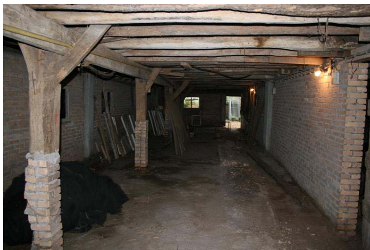
Het interieur aan de ankerbalkzijde vanaf de voorgevel.
