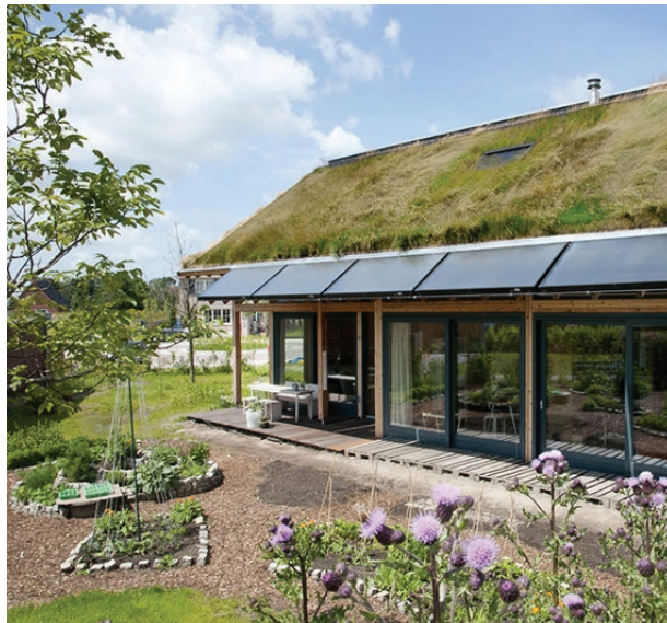
Ecologisch bouwen; zonnepanelen en groen dak
