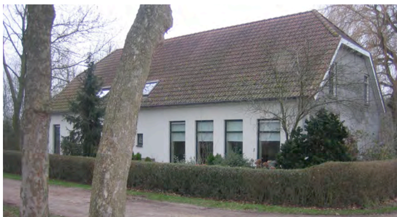
Voormalige bedrijfswoning, gezien vanaf de Zoeksedijk.
