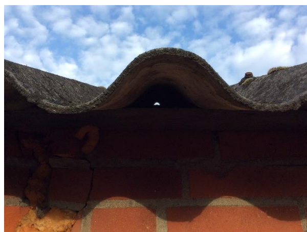
Foto 11: Ruimte onder golfplaten
