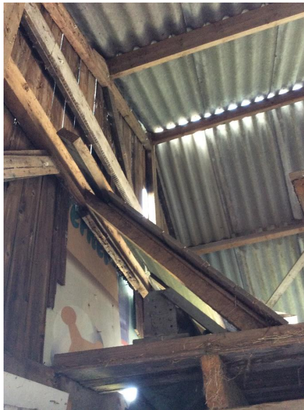
Foto 9: Dak en dakbeschoot N-schuur
